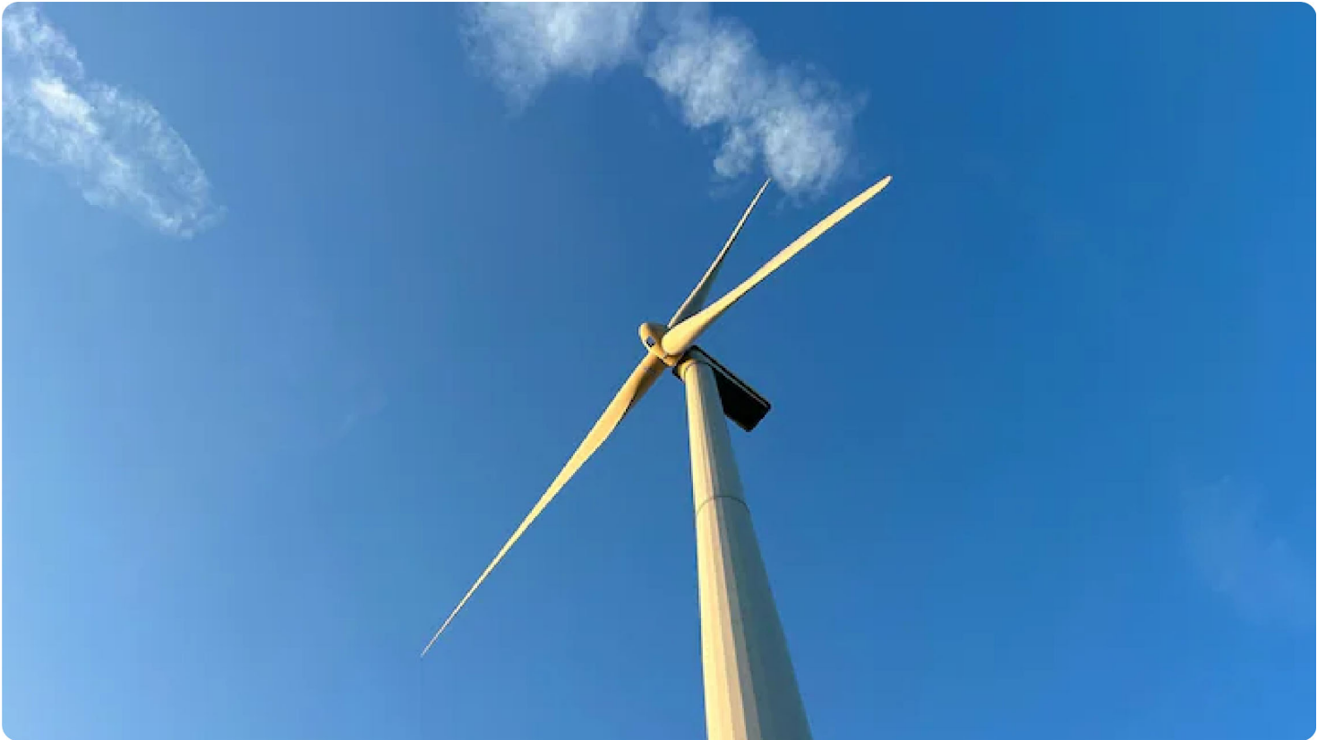
Le futur parc éolien.
